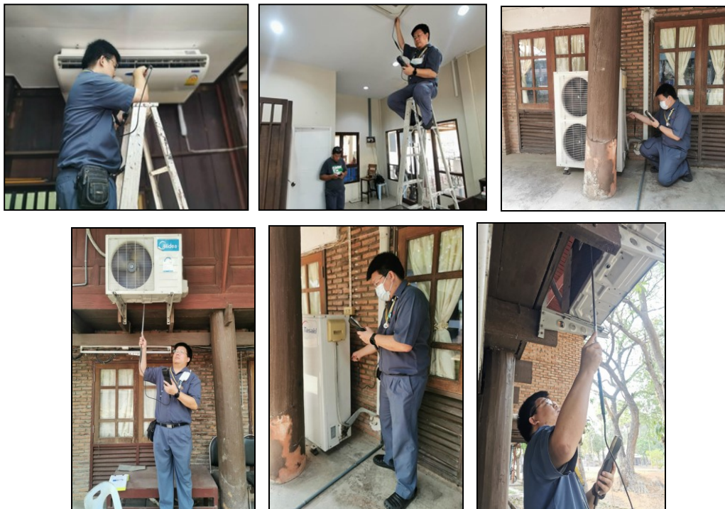
รูปที่ ข-1 การตรวจวัดประสิทธิภาพการใช้พลังงานของเครื่องปรับอากาศ
